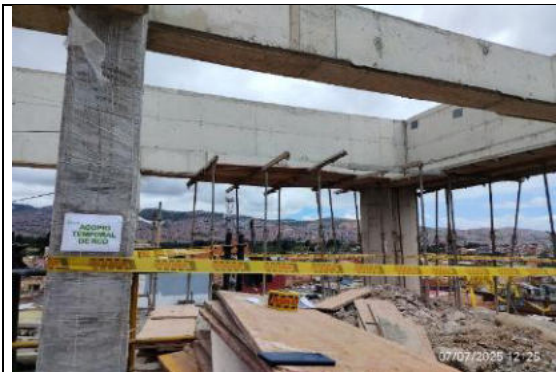
Fundida de vigas de cubierta 07/07/2025
