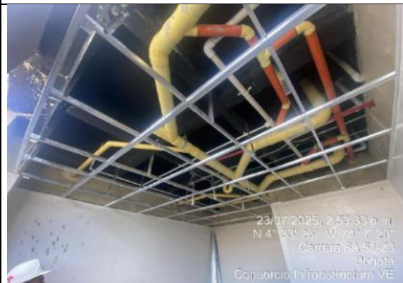
Armado de estructura para cielo raso 23/07/2025
