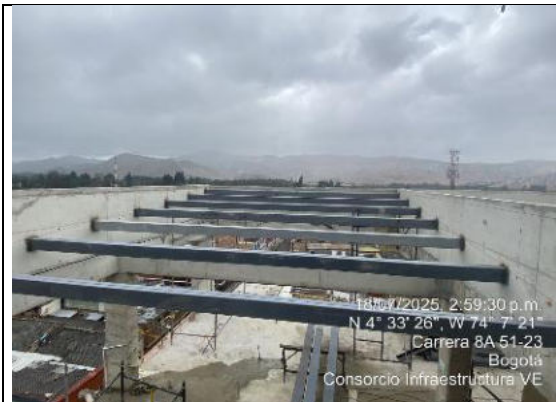
Instalación de Estructura metálica para cubierta 18/07/2025
