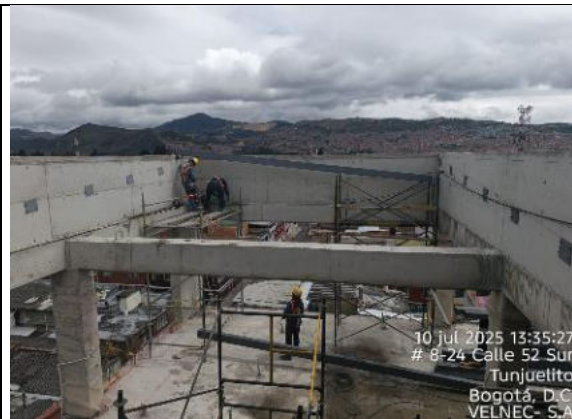
Instalación de estructura metálica para cubierta 10/07/2025
